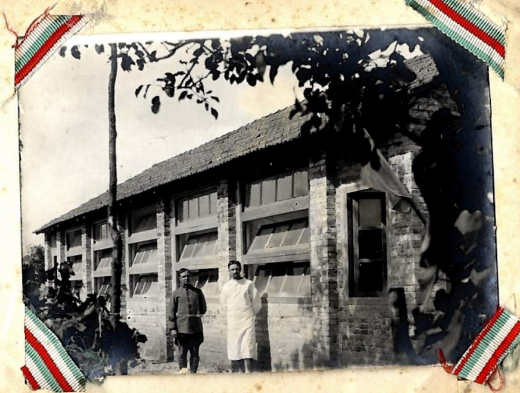
XVII. - Locale Isolamento
