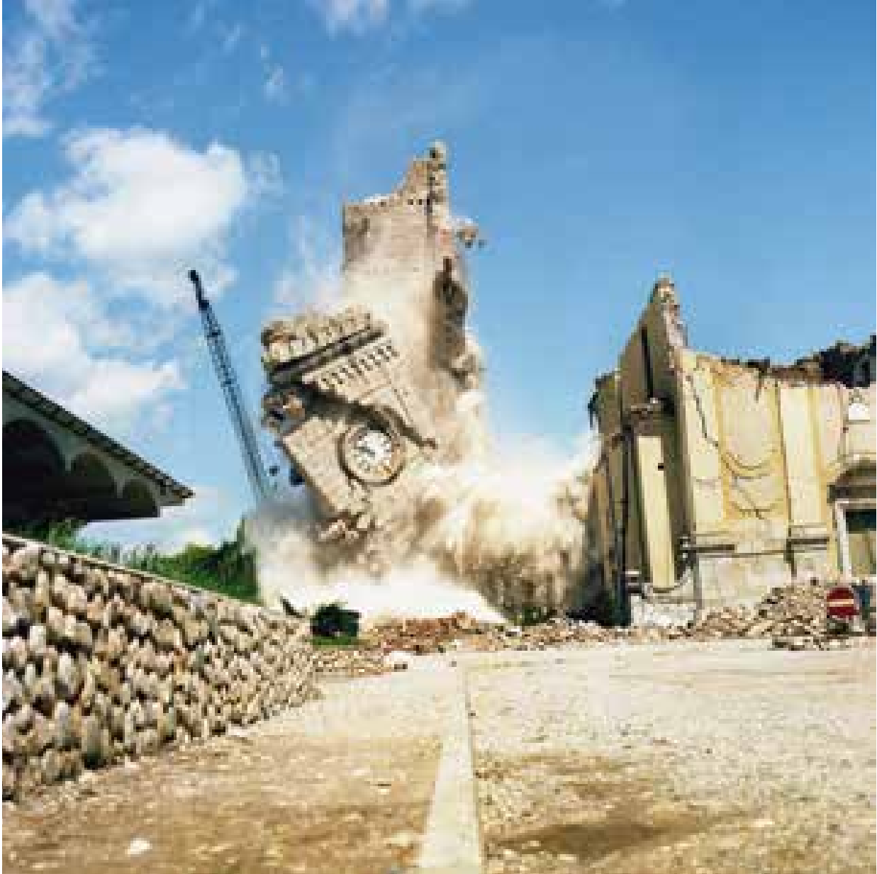
MAJANO. La demolizione del pericolante campanile della chiesa parrocchiale. R. Viola
