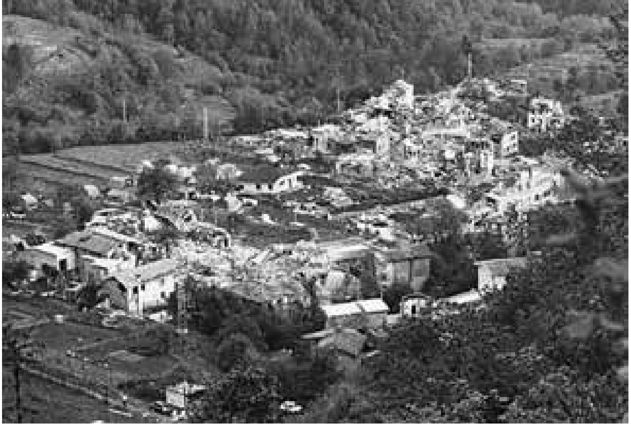
MONTENARS. Le borgate di Isola e Bulons
