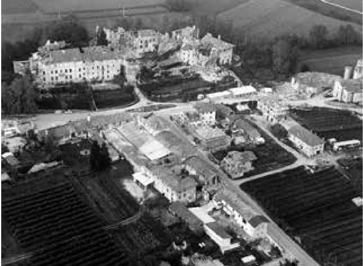
COLLOREDO DI MONTE ALBANO. Complesso castellano e borgo
