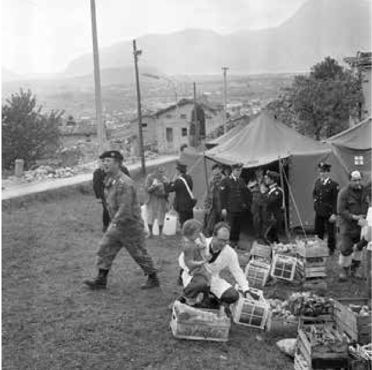
Tra MONTENARS e GEMONA DEL FRIULI. Distribuzione di derrate alimentari. E. Pavonello
