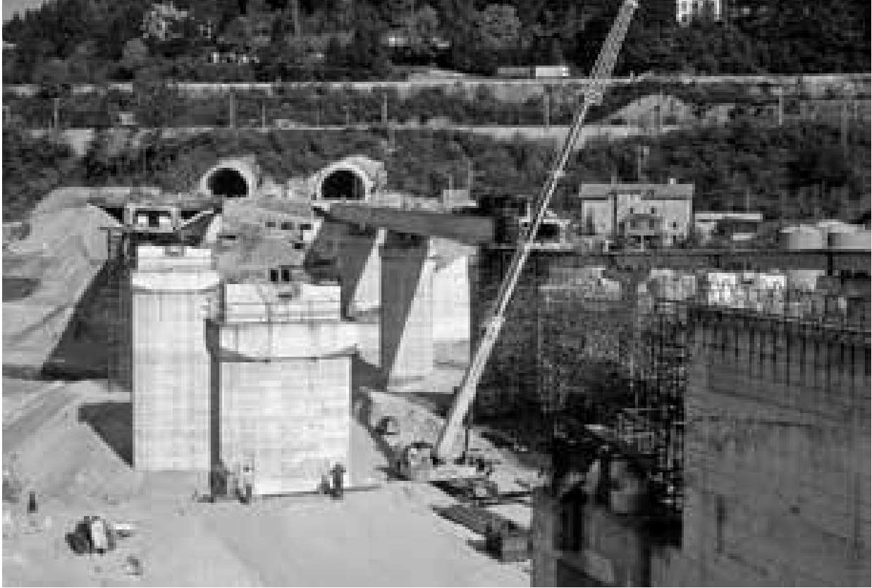
Viadotti dell'autostrada A23 in costruzione
