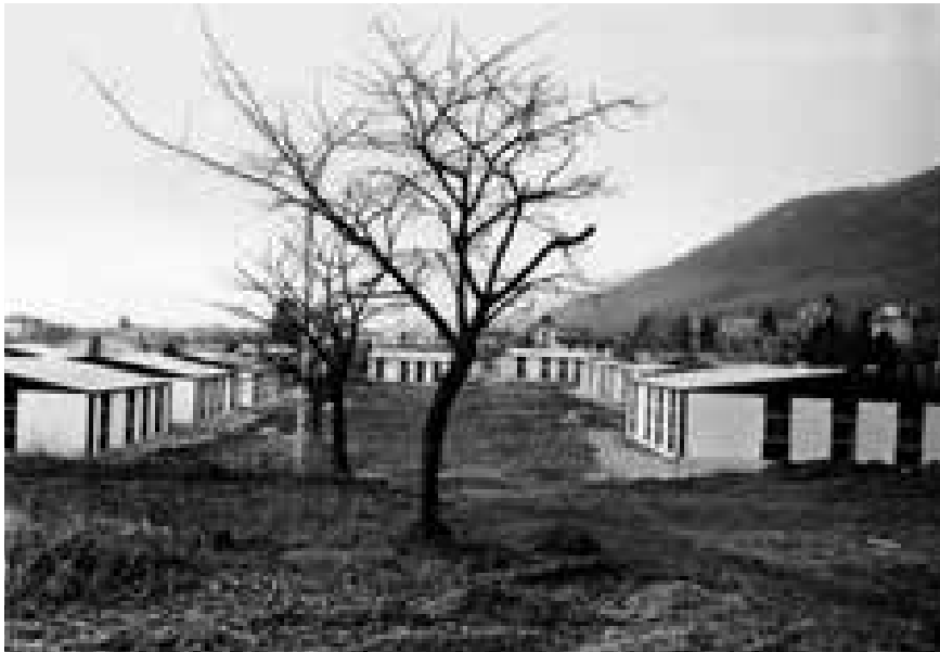
TRICESIMO. Prefabbricato donato alla Parrocchia dalla Diocesi di Treviso da destinare a Scuola materna e Centro parrocchiale. Furono un'ottantina le Diocesi che 'adottarono' altrettante Comunità terremotate
