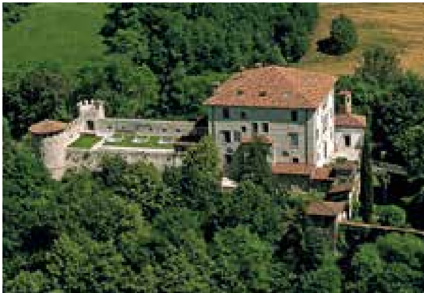
CAPORACCO (Colloredo di Monte Albano). La ricostruzione del castello crollato con il sisma
