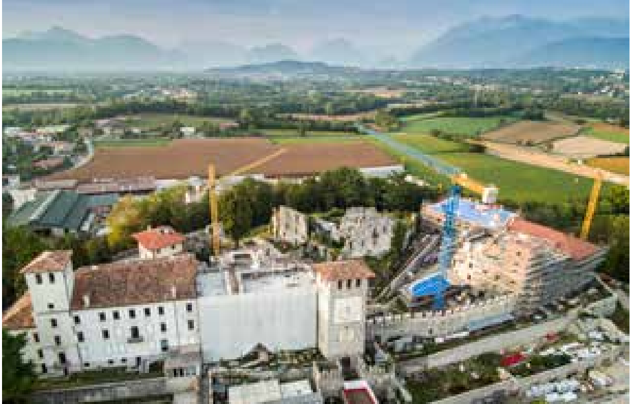
COLLOREDO DI MONTE ALBANO. Il complesso castellano in fase di ricostruzione. E. Cossetini
