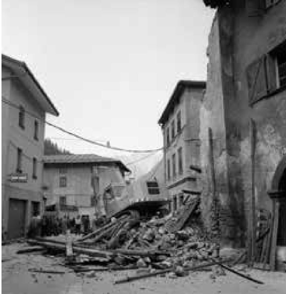
PONTEBALBA. Demolizioni in via Roma.
