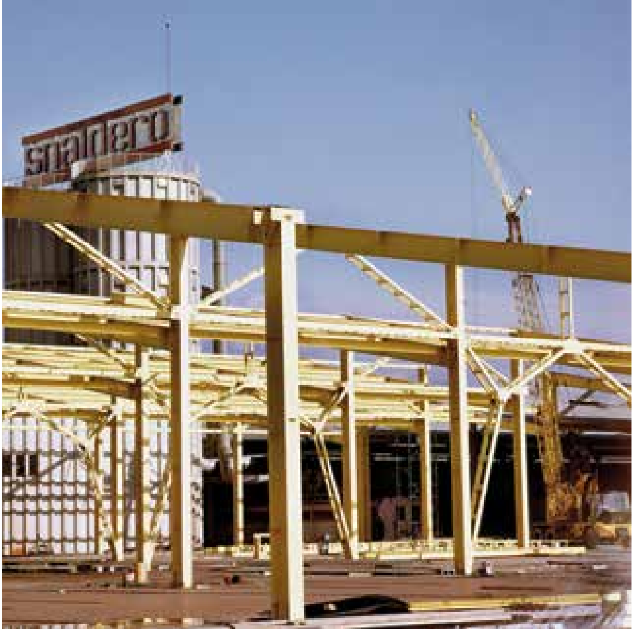
MAJANO. La ricostruzione dello stabilimento Snaidero. F.lli Di Leno
